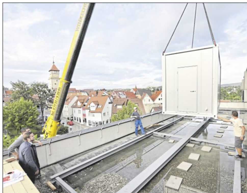
Mit einem Kran wurden Container auf die Dachterrasse vor der Bettenstation der Zentralklinik gehievt und miteinander verbunden. Für die kommenden Monate dienen sie als OP-Bereich.
